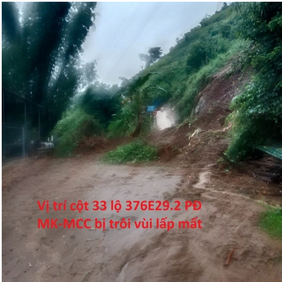
Khu vực cột điện tại Sơn La bị vùi lấp do sạt lở đất
