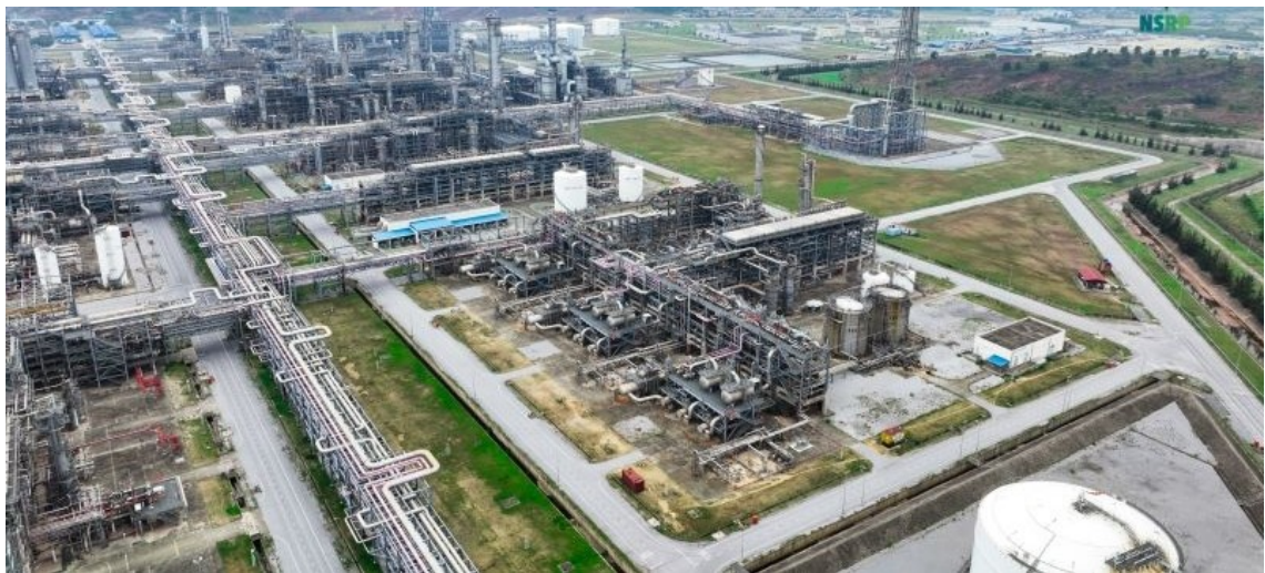
Toàn cảnh Nhà máy Lọc hóa dầu Nghi Sơn (ảnh NSRP cung cấp).
