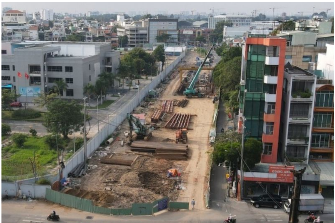
Thi công đường nối từ đường Cộng Hòa đến đường Trần Quốc Hoàn, Quận Tân Bình. Ảnh Tuấn Kiệt.
