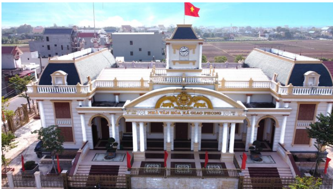
Nhà Văn hóa xã Giao Phong, huyện Giao Thủy, Nam Định được đầu tư xây dựng khang trang
