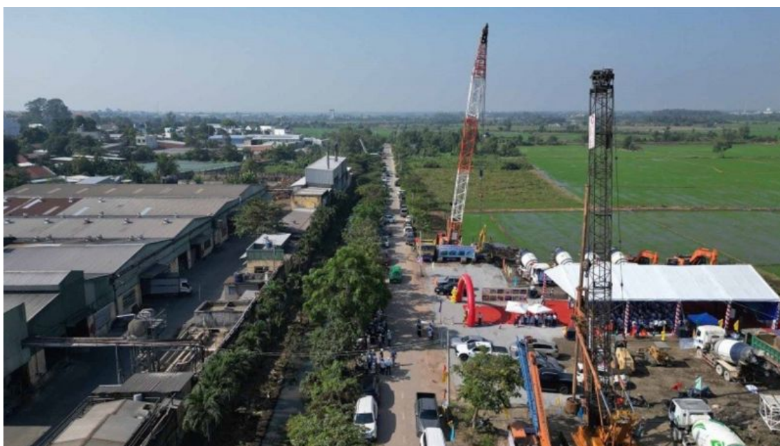
Máy móc thi công một đoạn Dự án đường Vành đai 3 đoạn qua huyện Hóc Môn, TP.HCM
