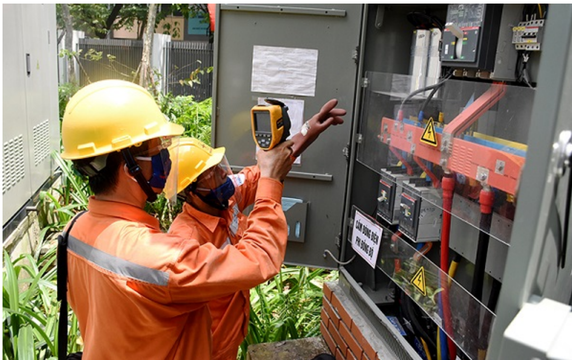
Kiểm tra điện - đảm bảo cấp điện an toàn, ổn định
