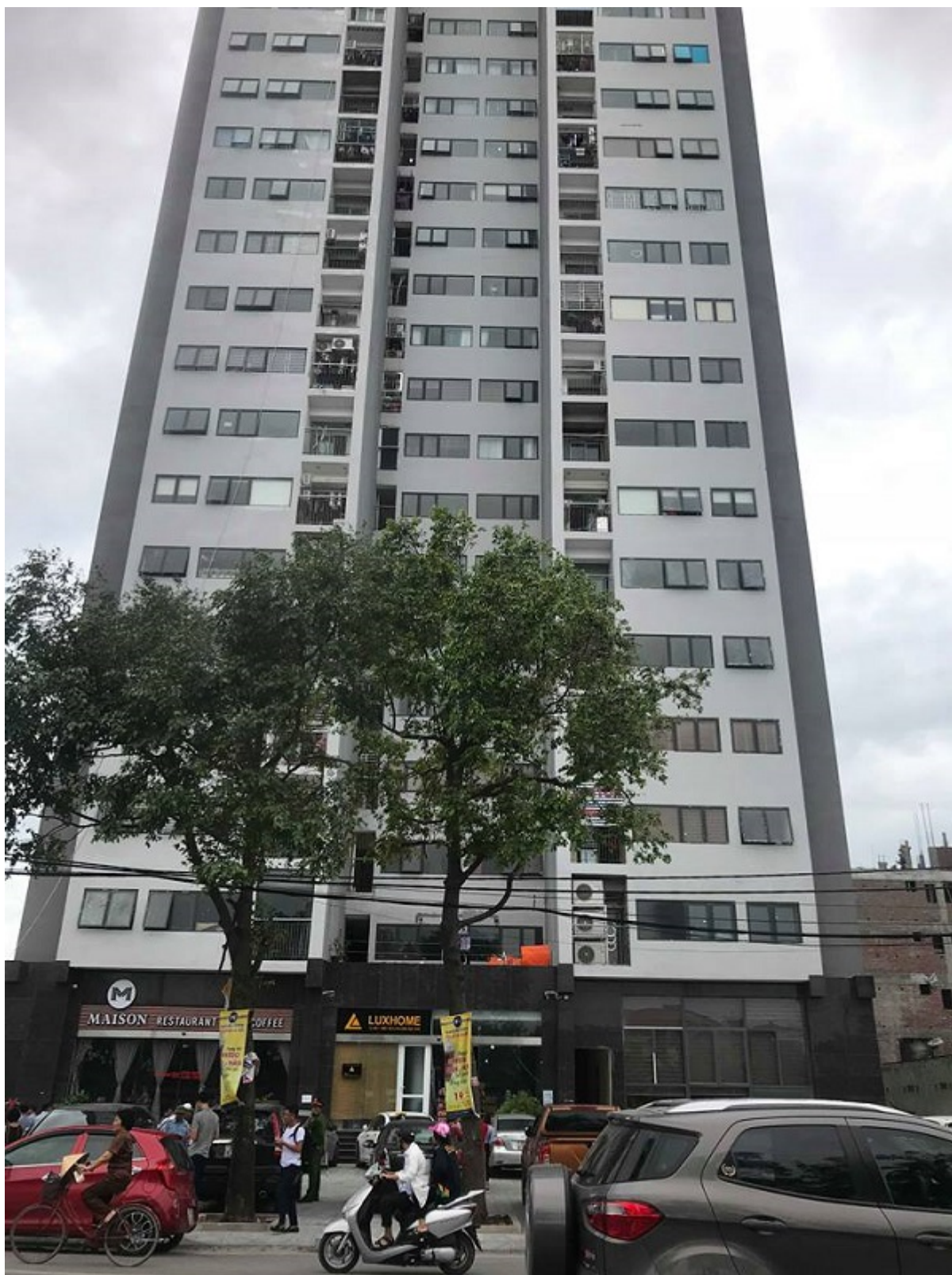
Tòa nhà chung cư Bảo Sơn Complex, số 126 đường Nguyễn Sỹ Sách, phường Hưng Phúc, TP. Vinh (Nghệ An) được xây dựng 31 tầng với 319 căn hộ cao cấp
