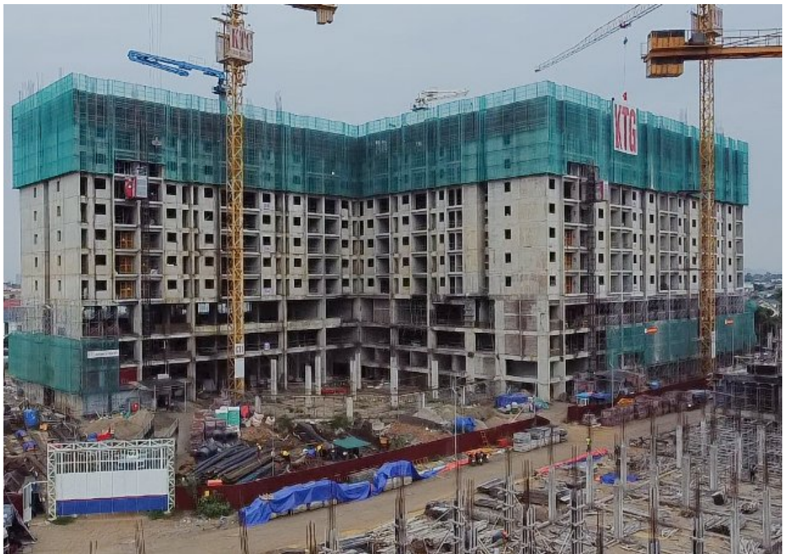
Một dự án nhà ở xã hội đang triển khai tại phường Vinh Lộc.
