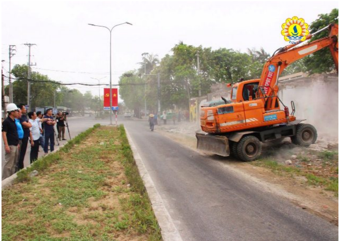
Cửa Lò tháo gỡ điểm nghẽn giao thông tại nút giao Bình Minh – Nguyễn Xí. (Ảnh: Phường Cửa Lò)
