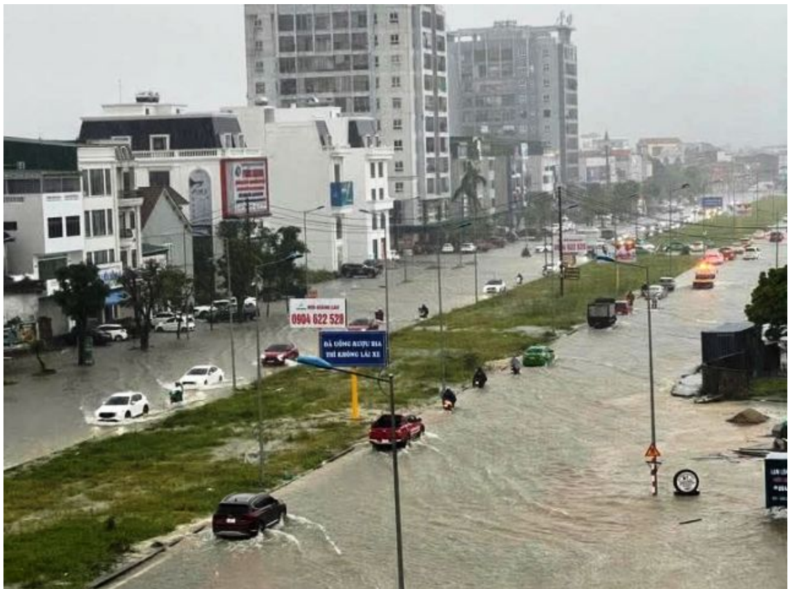
Sáng 27/9, mưa lớn khiến nhiều tuyến đường trên địa bàn TP. Vinh (cũ) chìm sâu trong nước.
