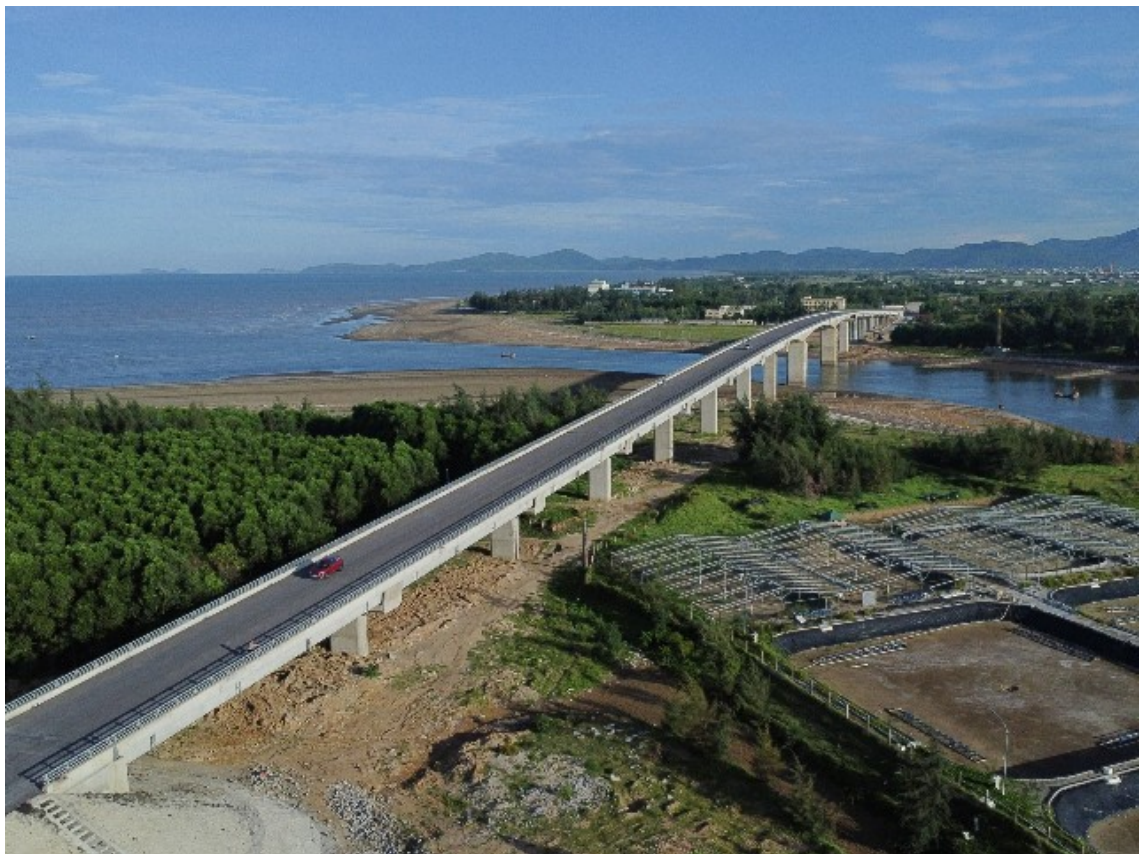
Dự án đường ven biển, đoạn đi qua tỉnh Nghệ An.
