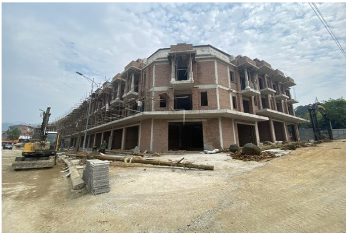
Các ki-ốt cao tầng đang được gấp rút hoàn thành
