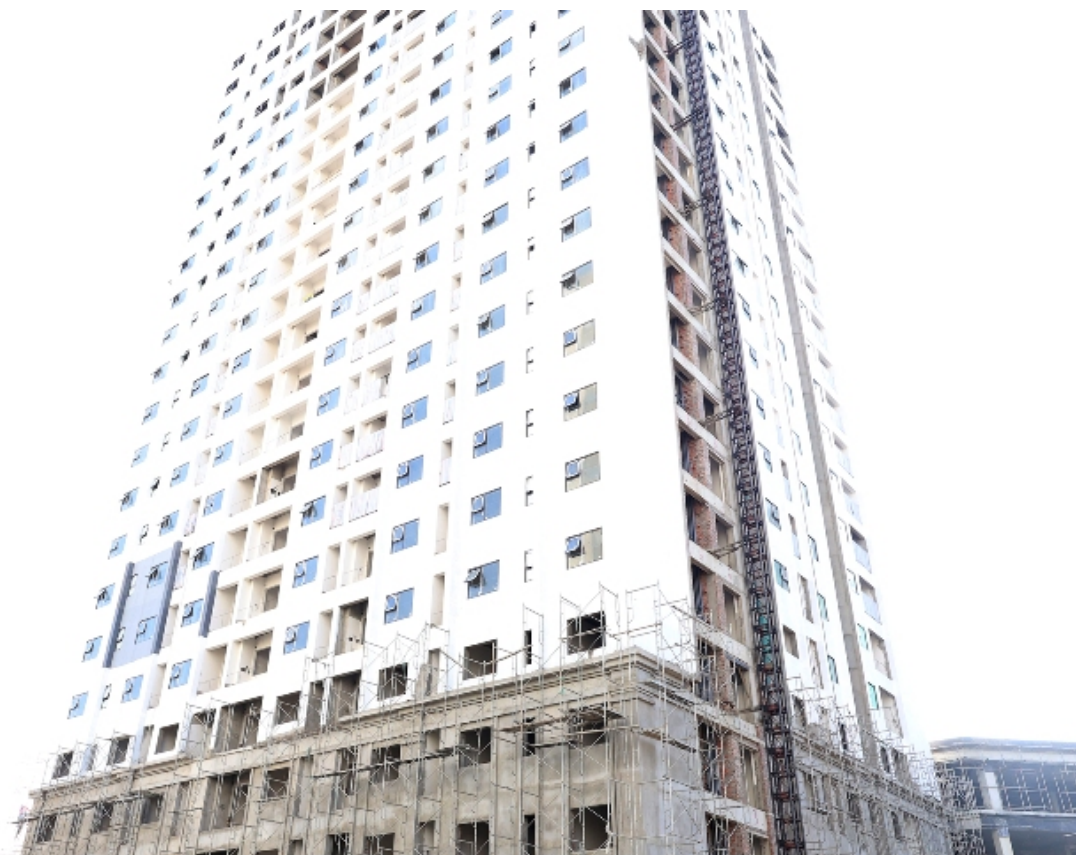
Tòa nhà CT3A đến nay đã hoàn thành phần thô, sớm đưa vào sử dụng. (Ảnh: Phan Quỳnh)
