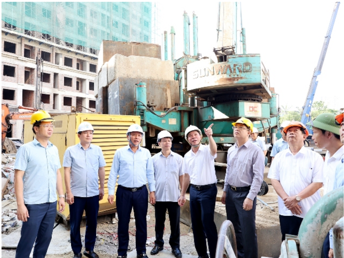
Đoàn kiểm tra hiện trường tại Dự án cải tạo, xây dựng lại Khu C Quang Trung. (Ảnh: Phan Quỳnh)
