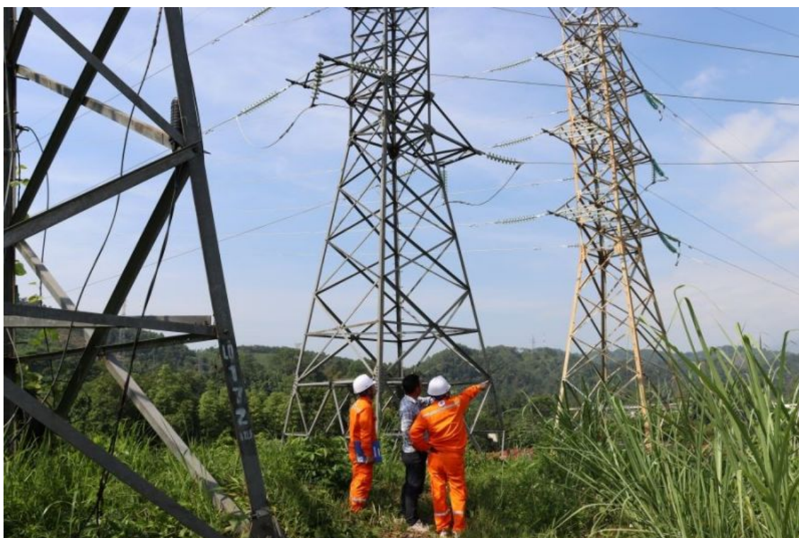
Kiểm tra vị trí đầu nối vào TBA 110kV Bắc Quang
