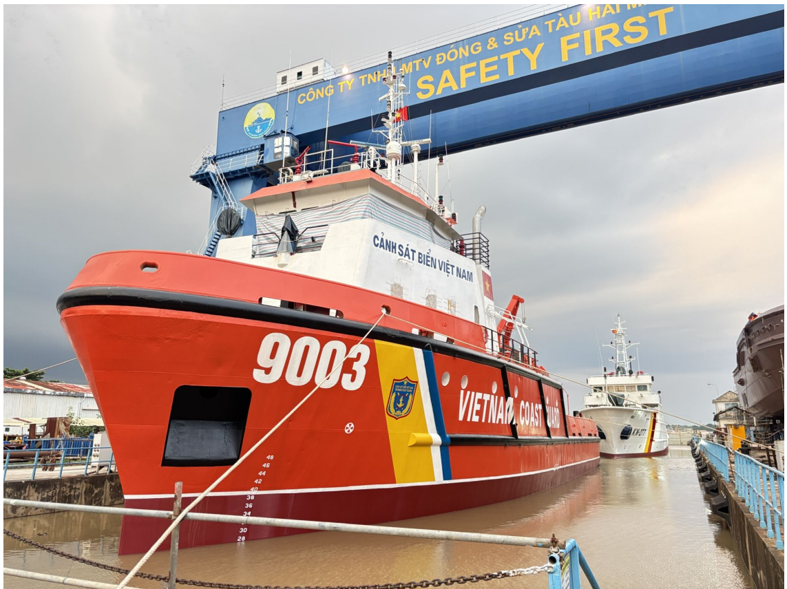
Tàu CSB 9003 hạ thủy kiểm tra thân vỏ sau sửa chữa
