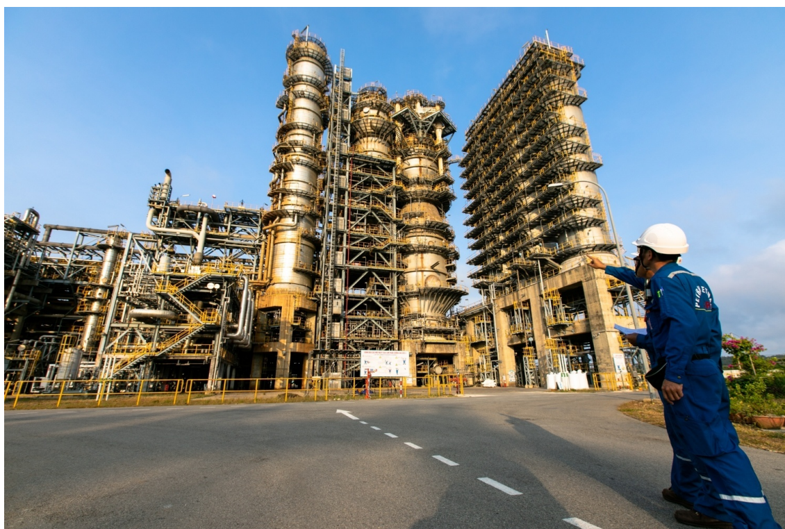
Nhân sự BSR kiểm tra công tác sản xuất tại Nhà máy Lọc dầu Dung Quất
