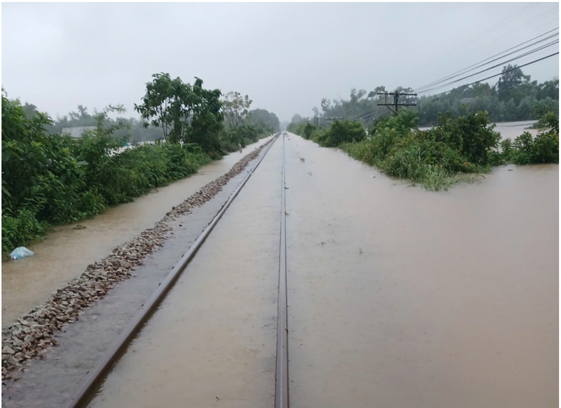
Nhiều đoạn đường sắt bị ngập
