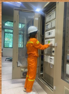
Kiểm tra thao tác tại tủ điều khiển bảo vệ
