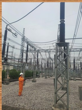
Thực hiện nhiệm vụ kiểm tra soi phát nhiệt thiết bị định kỳ
