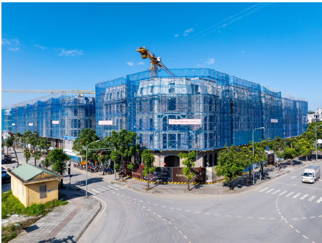
Noble Palace Long Bien đang được đẩy nhanh tiến độ thi công
