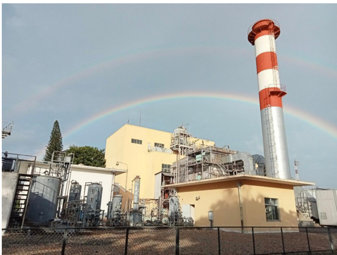
Tổ máy S4 – Nhà máy Nhiệt điện Cần Thơ.
