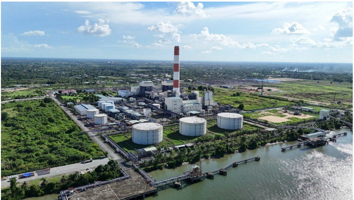
Nhà máy Nhiệt điện Ô Môn 1 - Công ty Nhiệt điện Cần Thơ, tổng công suất 660 MW
