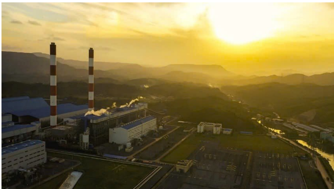
Toàn cảnh Công ty Nhiệt điện Mông Dương
