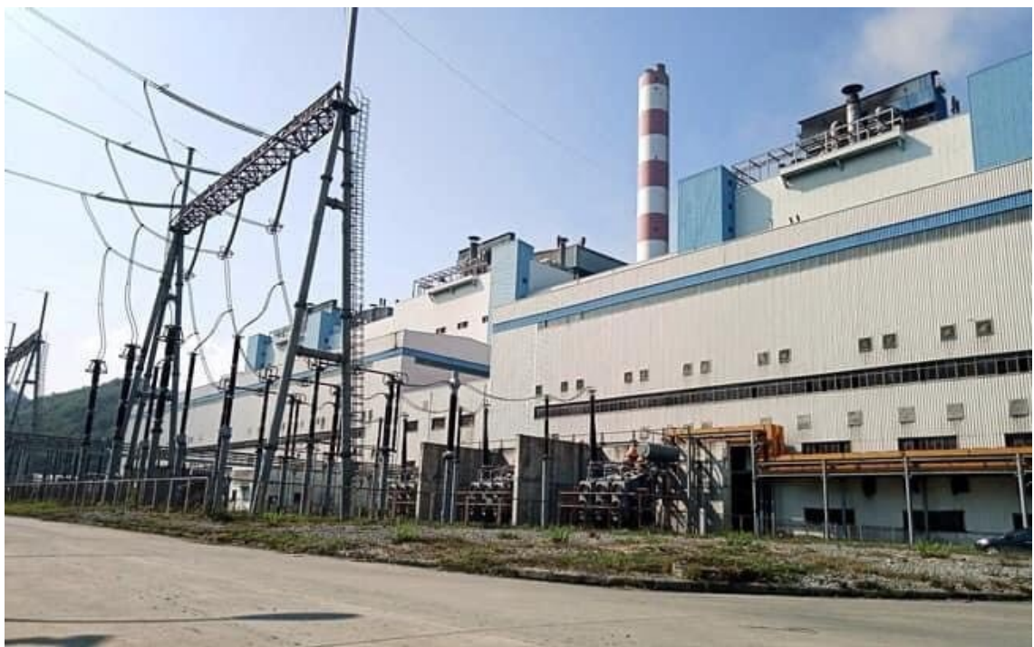
Nhà máy Nhiệt điện Quảng Ninh
