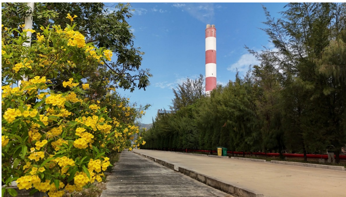
Phủ xanh khu vực kho than và khuôn viên Nhà máy
