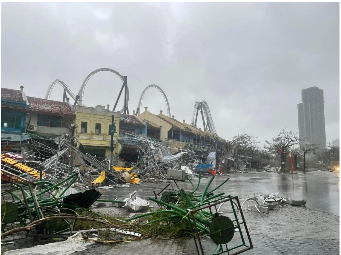
Cả dãy phố cổ Sun World, Hạ Long tan hoang
