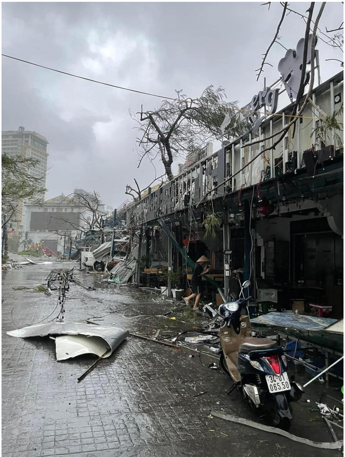
Cả dãy phố cổ Sun World, Hạ Long tan hoang
