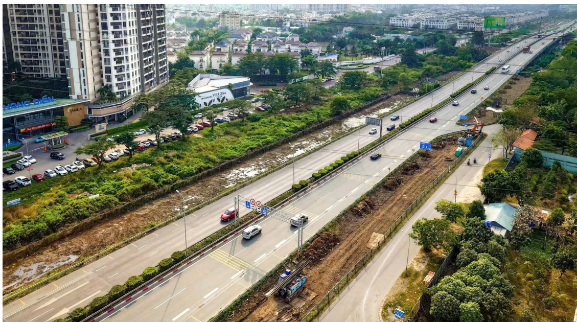
Dự án mở rộng cao tốc TP. HCM - Long Thành có chiều dài gần 22 km, bắt đầu từ nút giao Vành đai 2 (TP. HCM) đến nút giao cao tốc Biên Hòa - Vũng Tàu (Đồng Nai). (Ảnh: KT)
