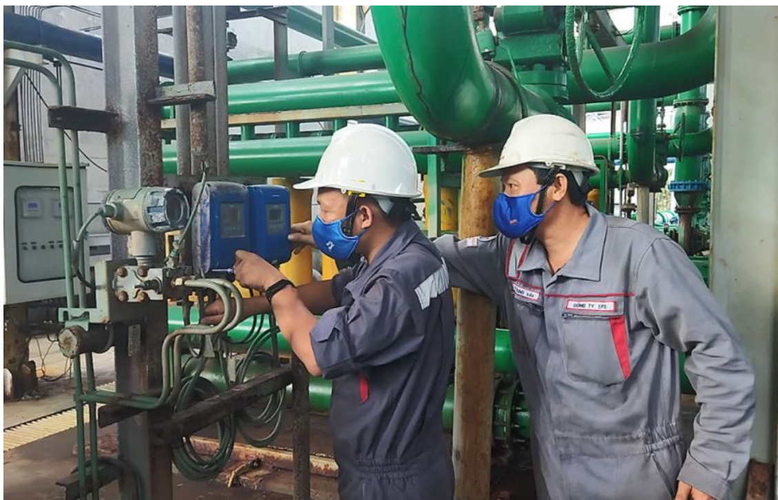
Kỹ sư EPS khắc phục lỗi thiết bị tại Nhà máy điện Vĩnh Tân 2
