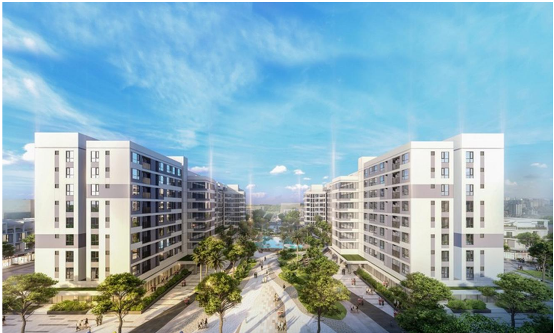
Dự án Khu nhà ở xã hội tại phường Đồng Văn, tỉnh Ninh Bình
