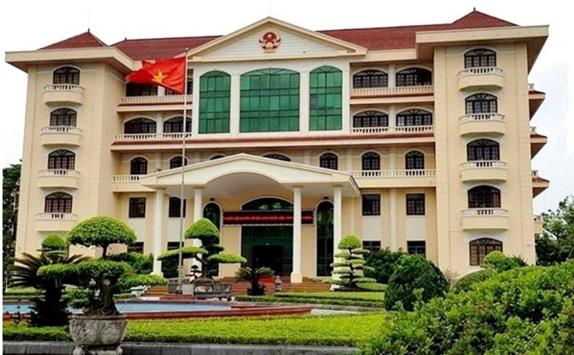
Trụ sở UBND tỉnh Ninh Bình
