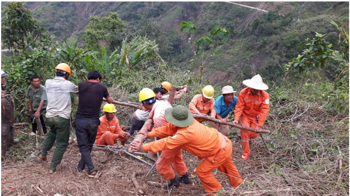
Nỗ lực cấp điện trở lại sau mưa lũ tại các tỉnh miền núi phía Bắc
