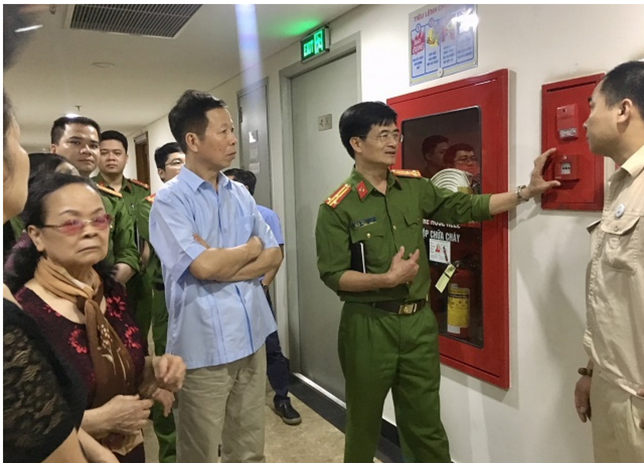
Thượng tá Trịnh Hữu Thực kiểm tra công tác PCCC tại tòa nhà Victoria Văn Phú ngày 30/3/2018.
