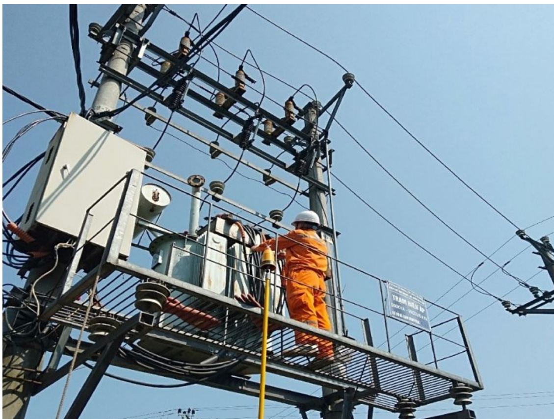
Công nhân Điện lực Lục Ngạn thực hiện vệ sinh công nghiệp các TBA phân phối trước mùa thu hoạch vải thiều năm 2023
