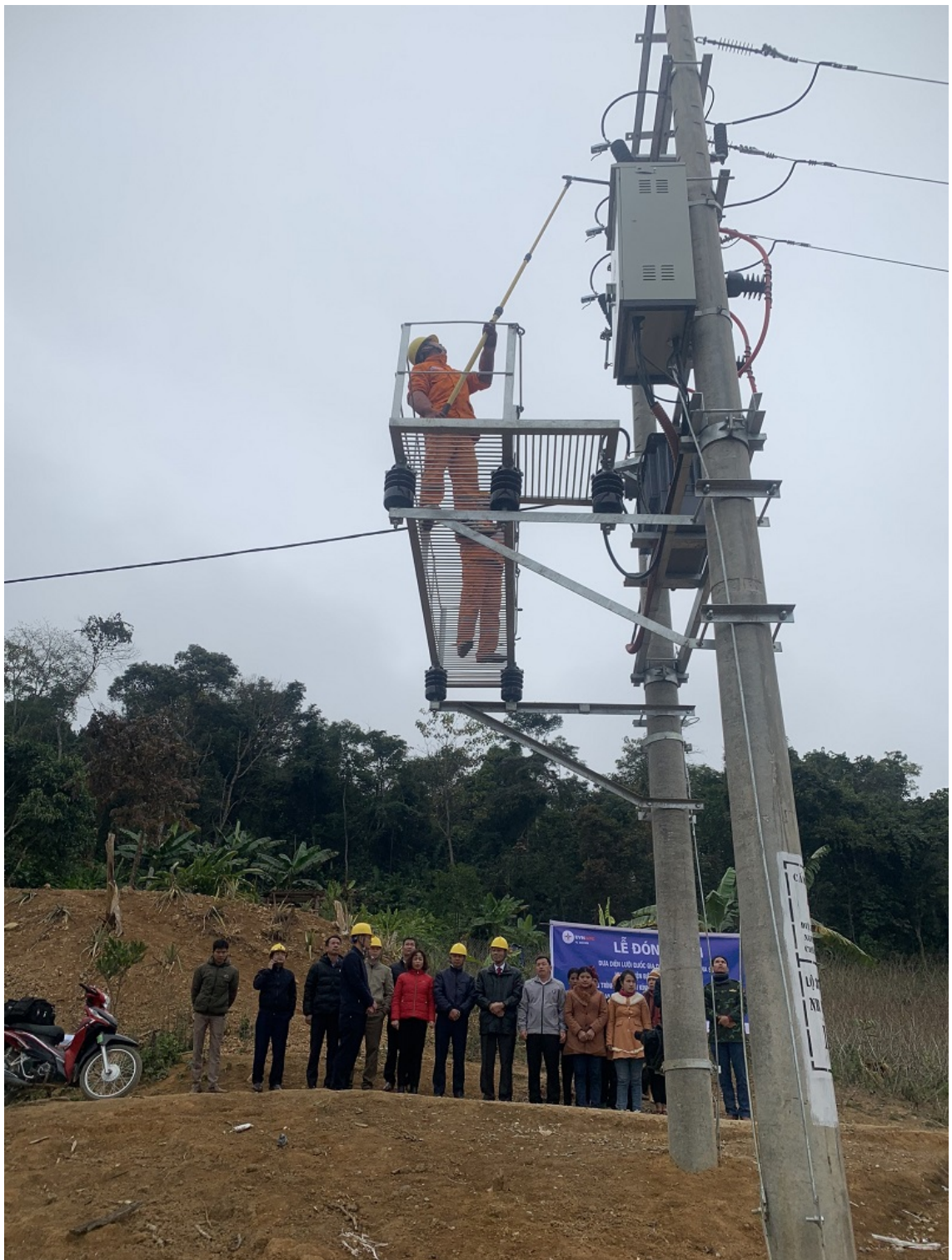
Công nhân Điện lực Điện Biên Đông đóng điện TBA Ho Cớ, Pá Chuông xã Na Son.
