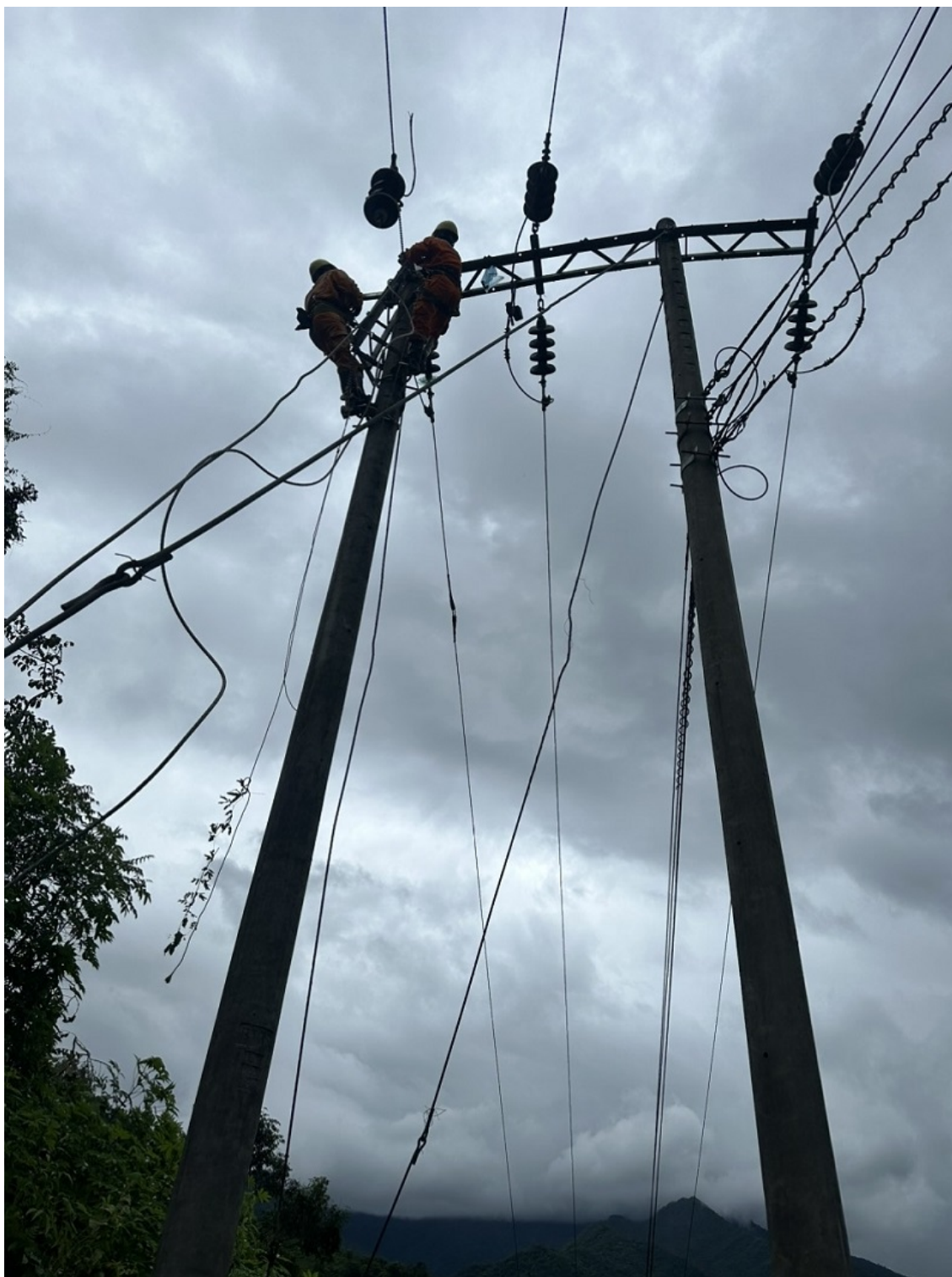
Công nhân Điện lực Mường Chà khắc phục sự cố đứt dây, gãy xà do sạt taluy cây đổ vào đường dây tại khoảng cột 222 - 224 thuộc ĐZ 35kV lộ 371E21.7
