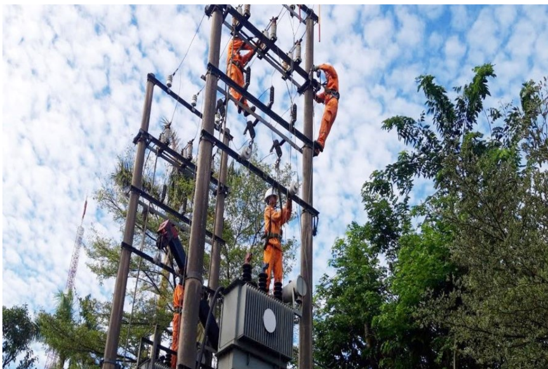
Công nhân Đội QLĐLKV Thành Sen nâng cấp, cải tạo TBA cấp điện cho Trung tâm Văn hóa - Điện ảnh và Xúc tiến du lịch tỉnh.
