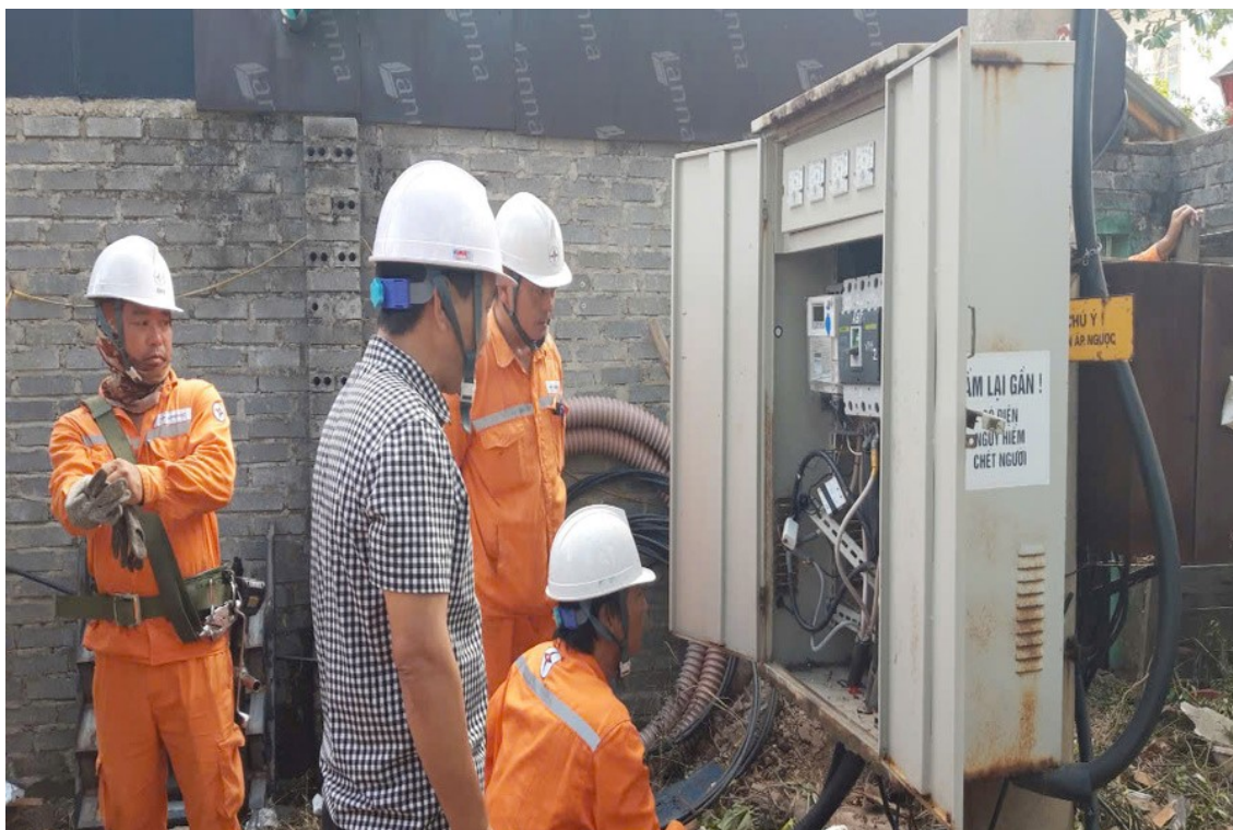
Công nhân Đội QLĐLKV Thành Sen tiến hành kiểm tra và thay thế các thiết bị đóng cắt tại tủ 0,4 kV tại TBA Trung tâm Văn hóa - Điện ảnh và xúc tiến du lịch tỉnh.
