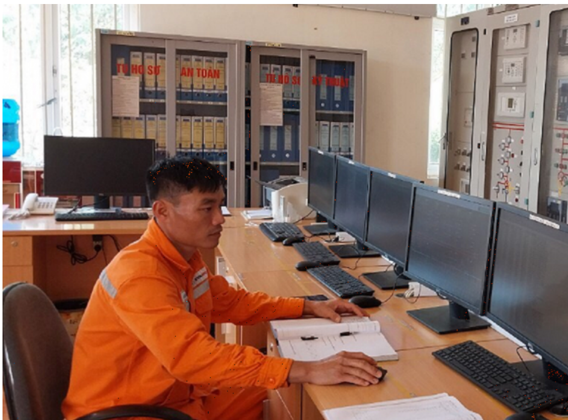
Giám sát thao tác từ trung tâm điều khiển xa qua hệ thống máy tính TBA 110kV Kỳ Sơn.
