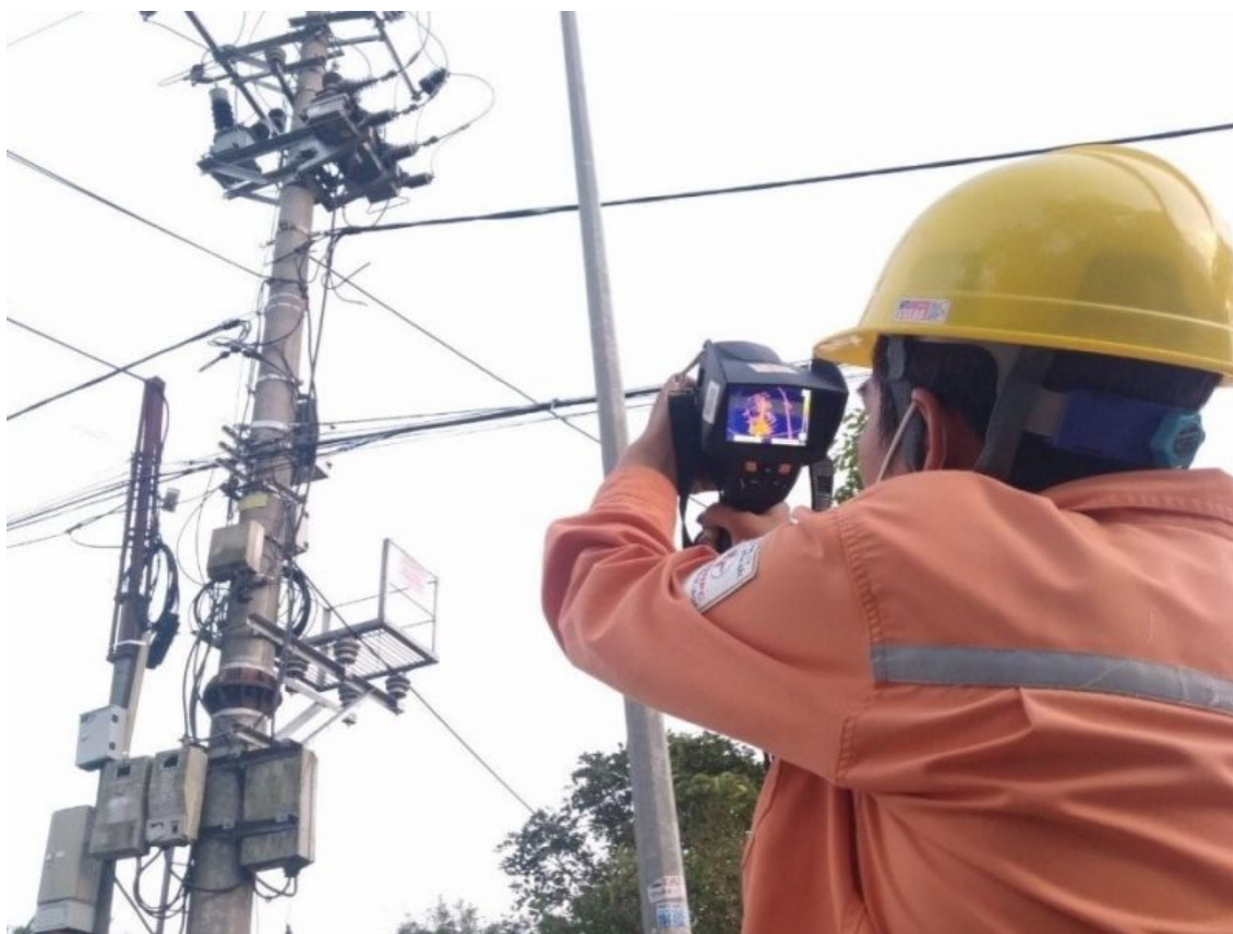
Công nhân Điện lực Thành phố kiểm tra lưới điện bằng Camera nhiệt.
