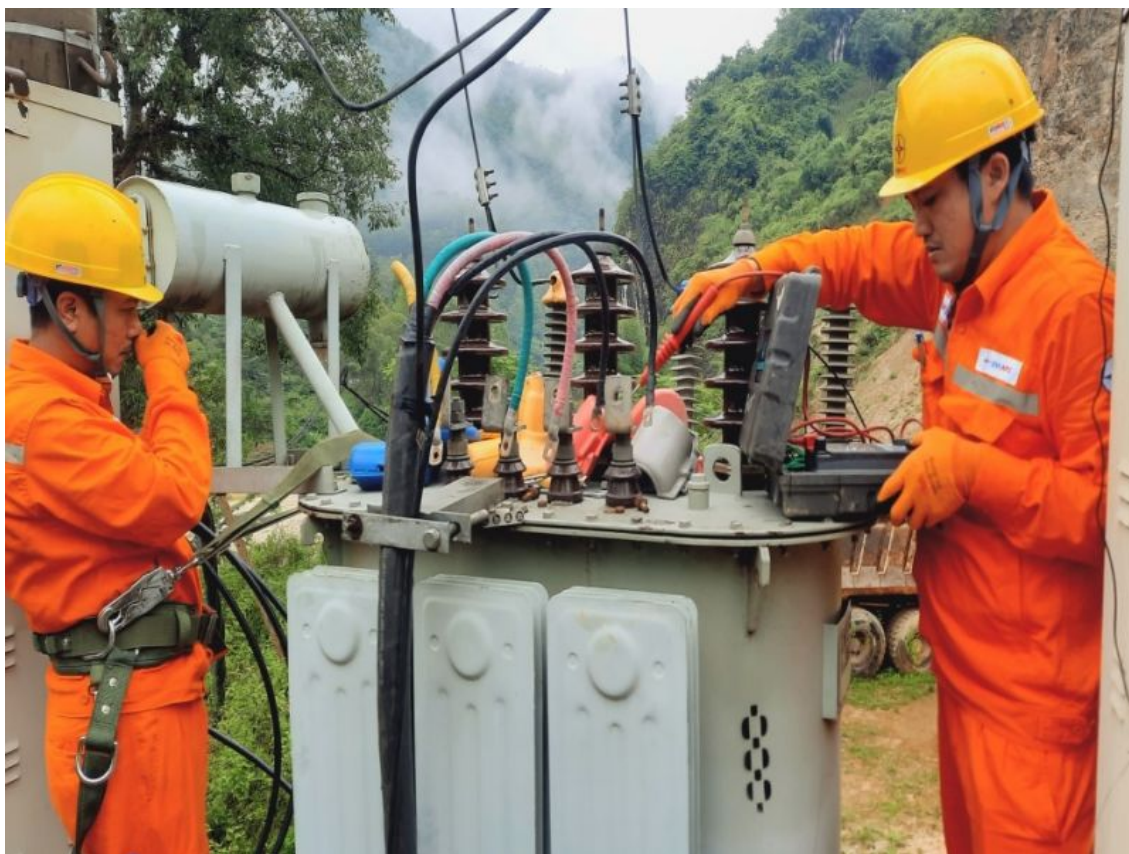
Công nhân Đội Quản lý vận hành lưới điện cao thế Lai Châu thí nghiệm TBA khách hàng.
