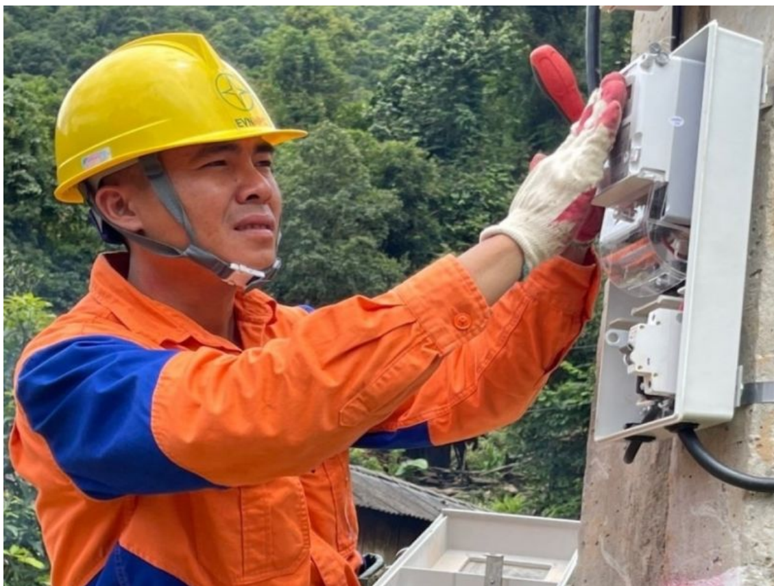
Công nhân Điện lực Sìn Hồ lắp đặt công tơ điện tử cho khách hàng.
