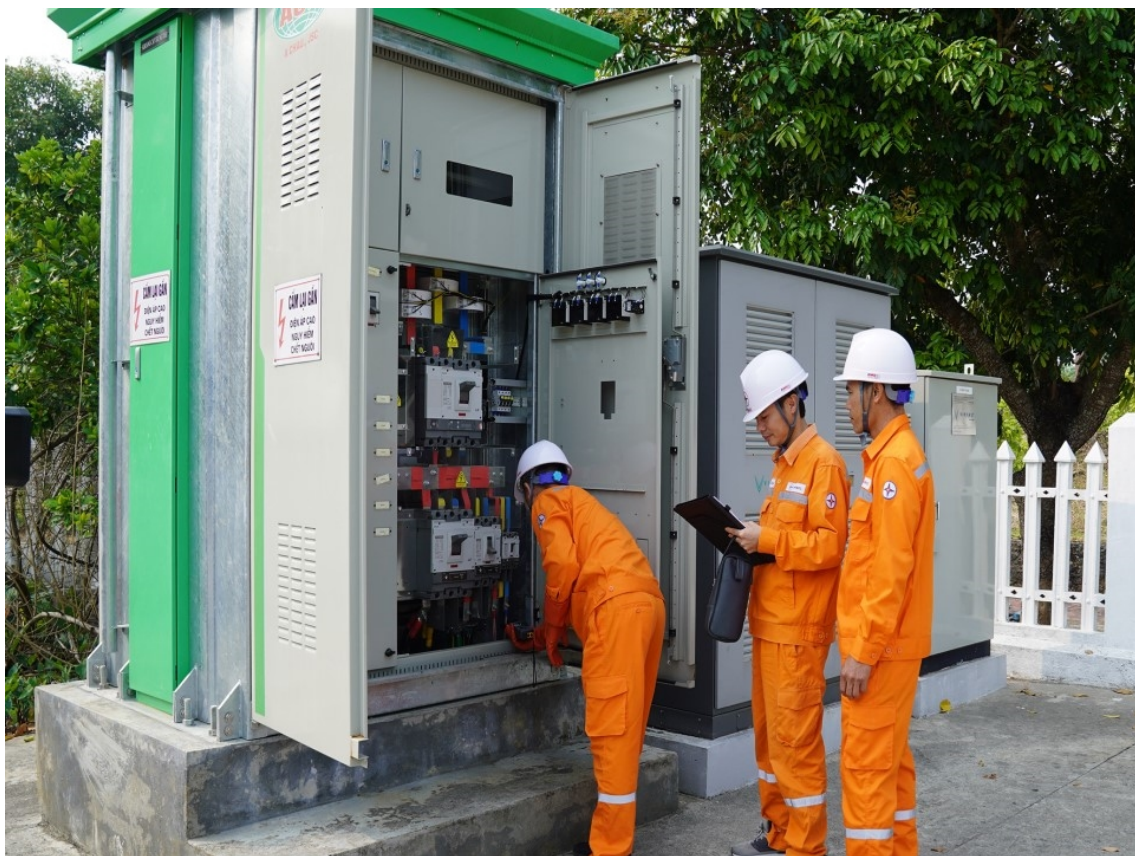
Công nhân Điện lực Thành phố Lai Châu kiểm tra TBA cấp điện cho khách hàng
