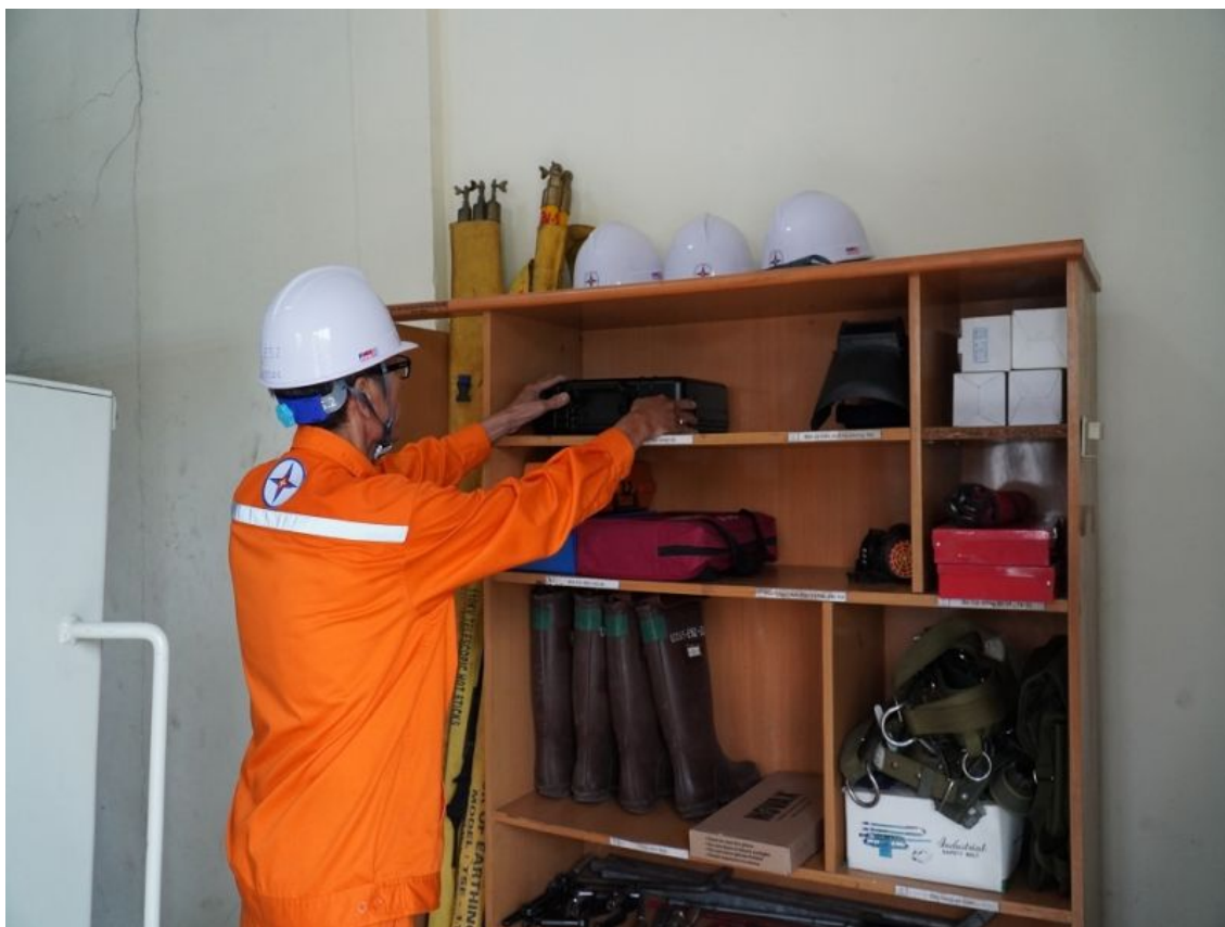
Công nhân TBA 110 kV Giáp Khẩu thực hiện 5S dụng cụ, trang thiết bị tại nơi làm việc
