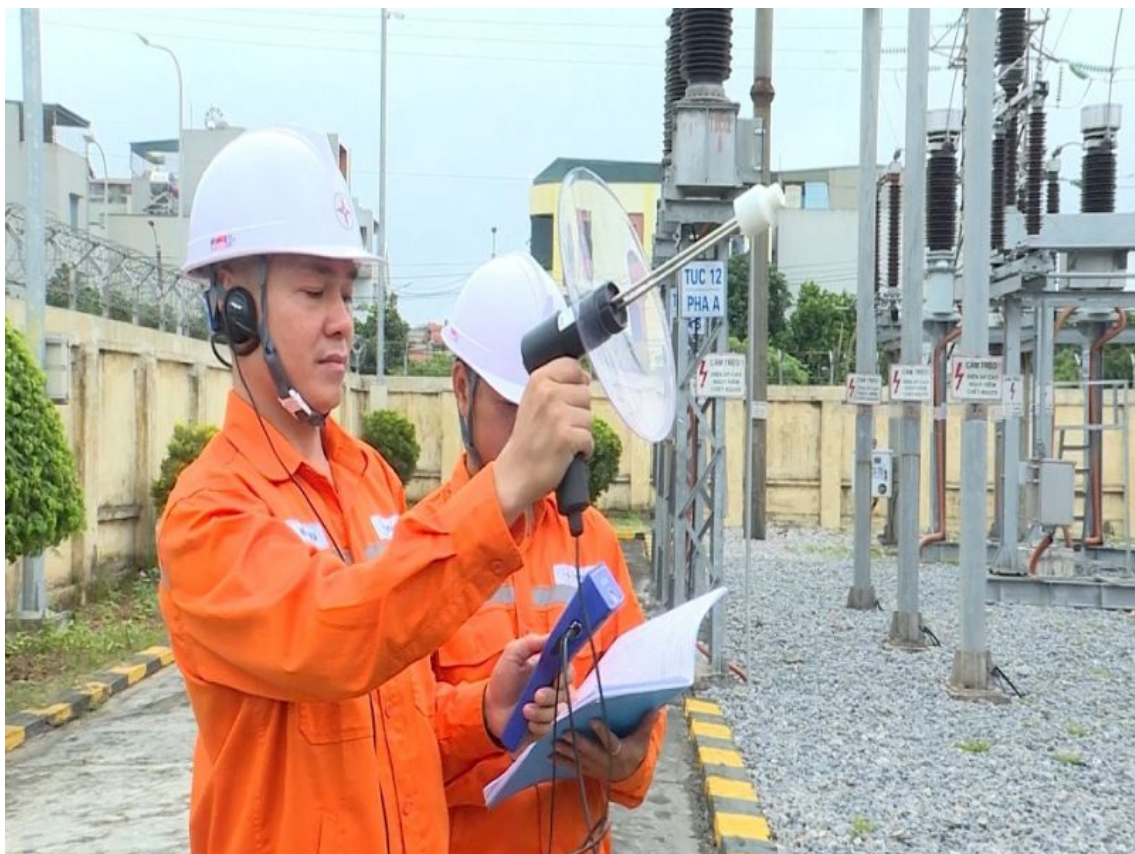
Công nhân Đội Quản lý vận hành Lưới điện cao thế kiểm tra phóng điện cục bộ cầm tay tại TBA 110kV Cái Lân.
