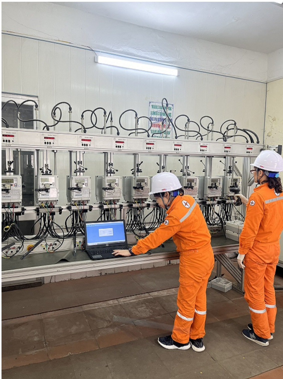
Công nhân Trung tâm Thí nghiệm Điện Quảng Ninh thực hiện kiểm định phương tiện đo
