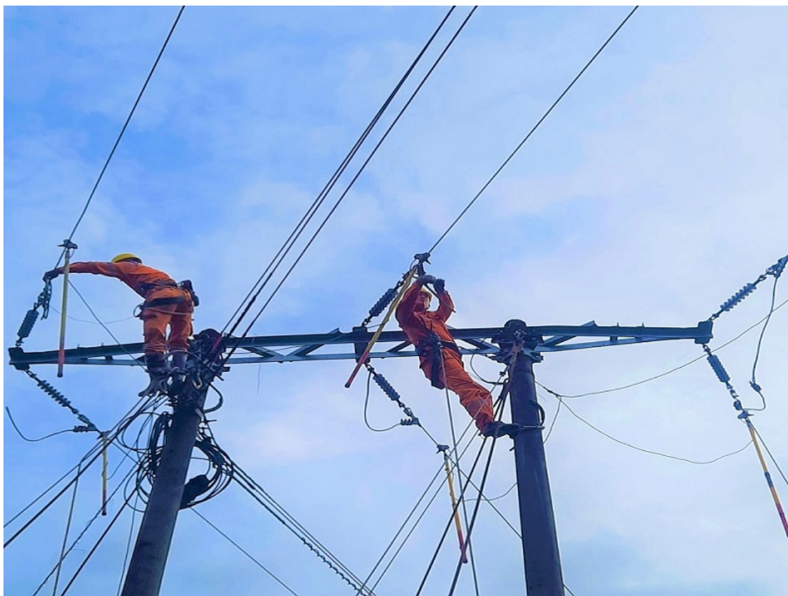
Công nhân Điện lực Tiên Yên xử lý khiếm khuyết trên đường dây.
