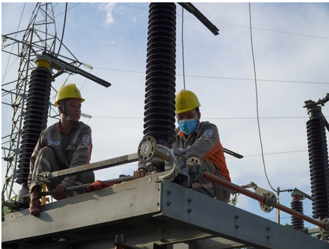
Công nhân Đội Quản lý vận hành lưới điện Cao thế Quảng Ninh, bảo dưỡng thiết bị TBA 110 kV Hà Tu.
