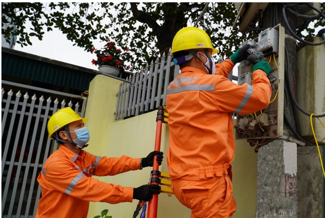
Công nhân Điện lực TP. Hạ Long thực hiện thay thế định kỳ công tơ cơ khí bằng công tơ điện tử đọc xa.
