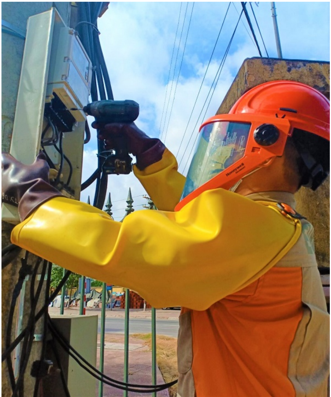
Công nhân Điện lực Tiên Yên lắp công tơ điện tử bằng phương pháp hotline
