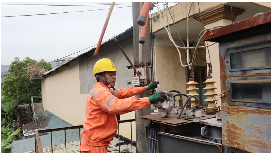
Công nhân Điện lực TP. Cẩm Phả vệ sinh trạm biến áp chuyên dùng Công ty Cổ phần nước khoáng Quang Hanh.
