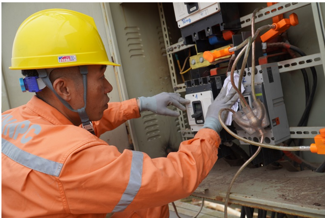
Vệ sinh trạm biến áp cho Công ty TNHH Vương Cường VT.
