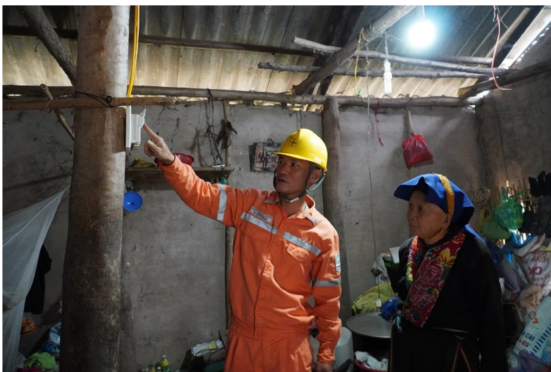
Sửa chữa hệ thống điện cho hộ nghèo xã Thanh Sơn, huyện Ba Chẽ.
