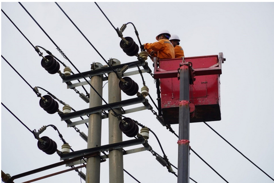
Công nhân PC Quảng Ninh xử lý khiếm khuyết trên đường dây trung thế
