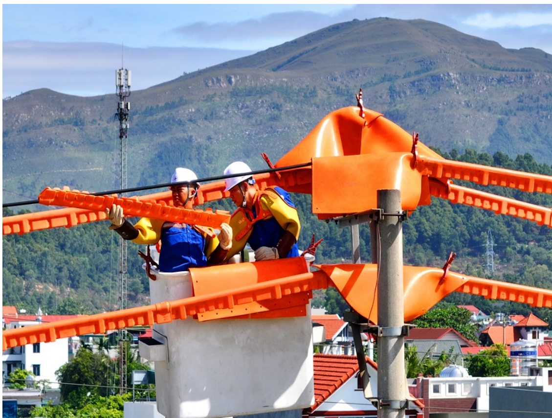
Công nhân Đội Hotline đang thực hiện phiên công tác trên lưới đang có điện
