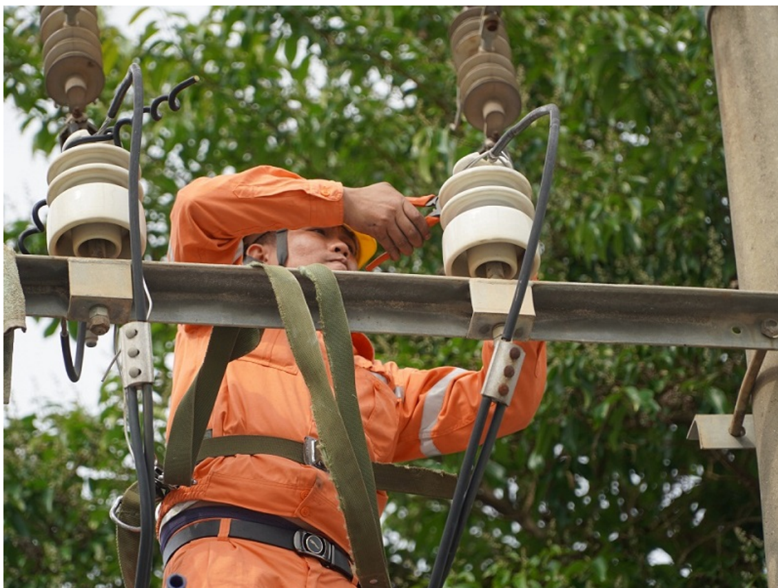
Công nhân Điện lực TP Cẩm Phả nghiệm thu công trình thuộc dự án KFW3.
