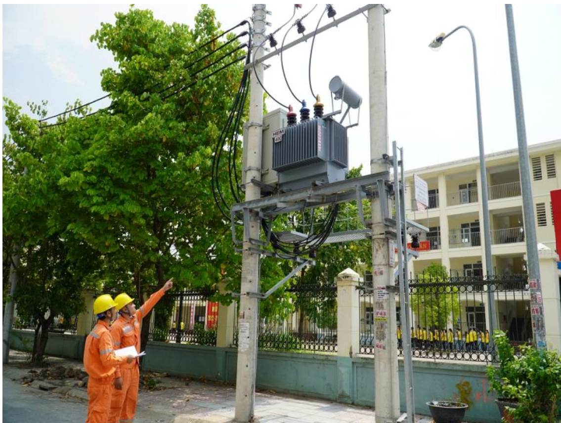
Các công trình sửa chữa lớn, chống quá tải được nghiệm thu đưa vào sử dụng đúng tiến độ, mang lại hiệu quả cao.
