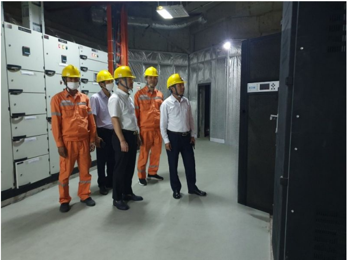
Ông Nguyễn Thanh Tĩnh - Bí thư Đảng ủy, Giám đốc PC Quảng Ninh trực tiếp kiểm tra việc đảm bảo cấp điện Seagames 31 tại hiện trường.
